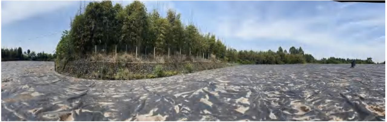
填埋库区（填埋库红线范围内全硬化，且填埋库区采取重点防渗，无法布点）
