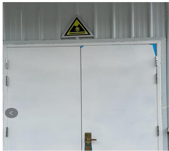
危险废物暂存间外部及标识牌
