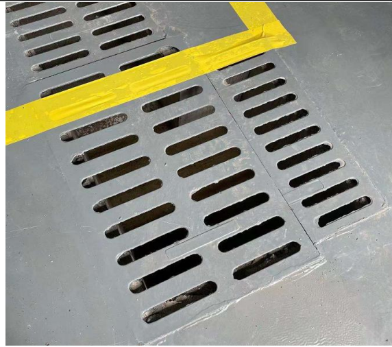
危险废物暂存间纳污池
