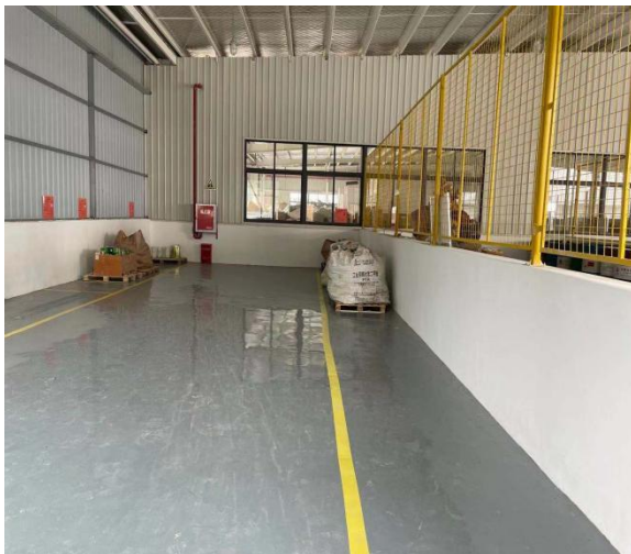
危险废物暂存间内部及标识牌
