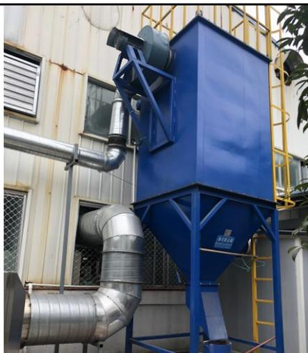
破碎粉尘脉冲袋式除尘器
