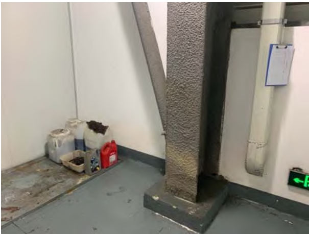
危废暂存间内
